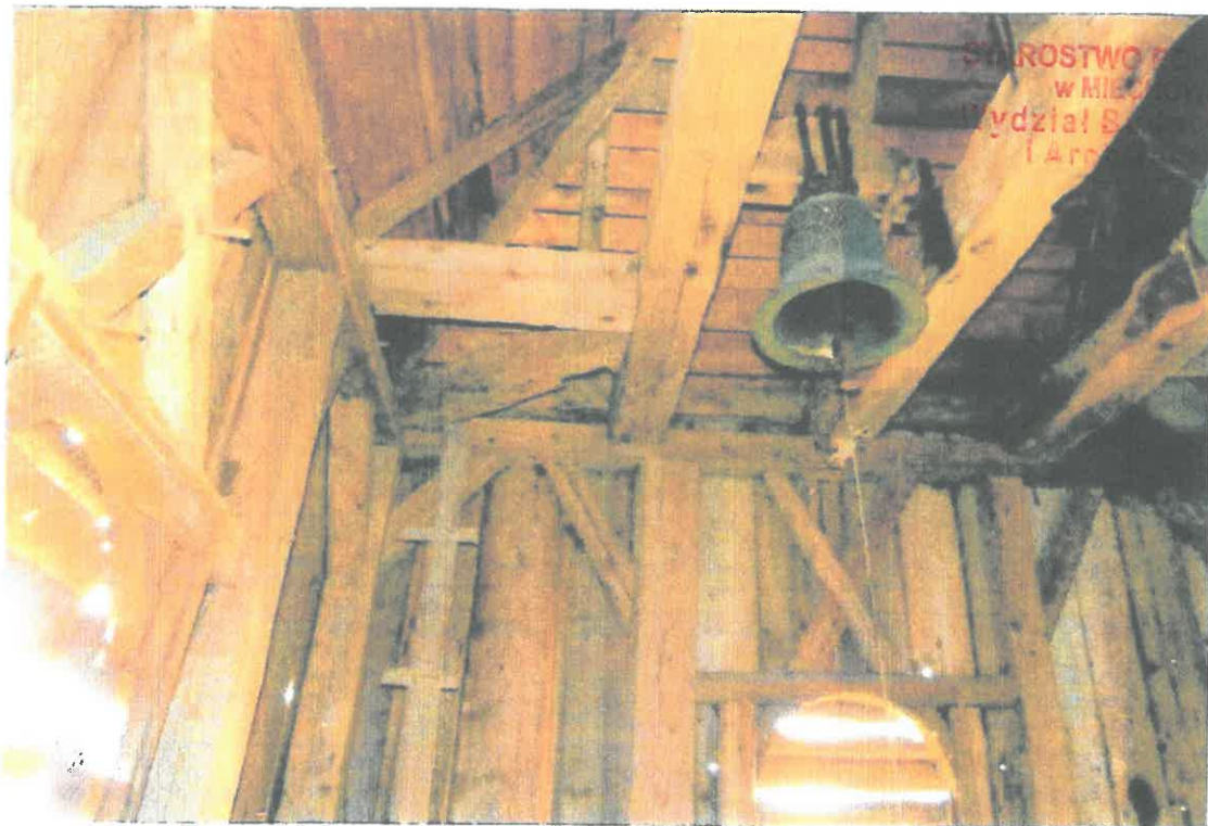
24. Nasiechowice, drewniana dzwonnica z 1740 r. – wnętrze dzwonnicy o konstrukcji słupowej z zawieszonym dzwonem.
