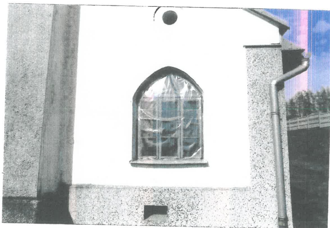
7. Nasiechowice, kościół p.w. ŚŚ. Wita, Modesta i Krescencji – wschodnia ściana zakrystii, cokół pokryty cementowym lastrykiem.
