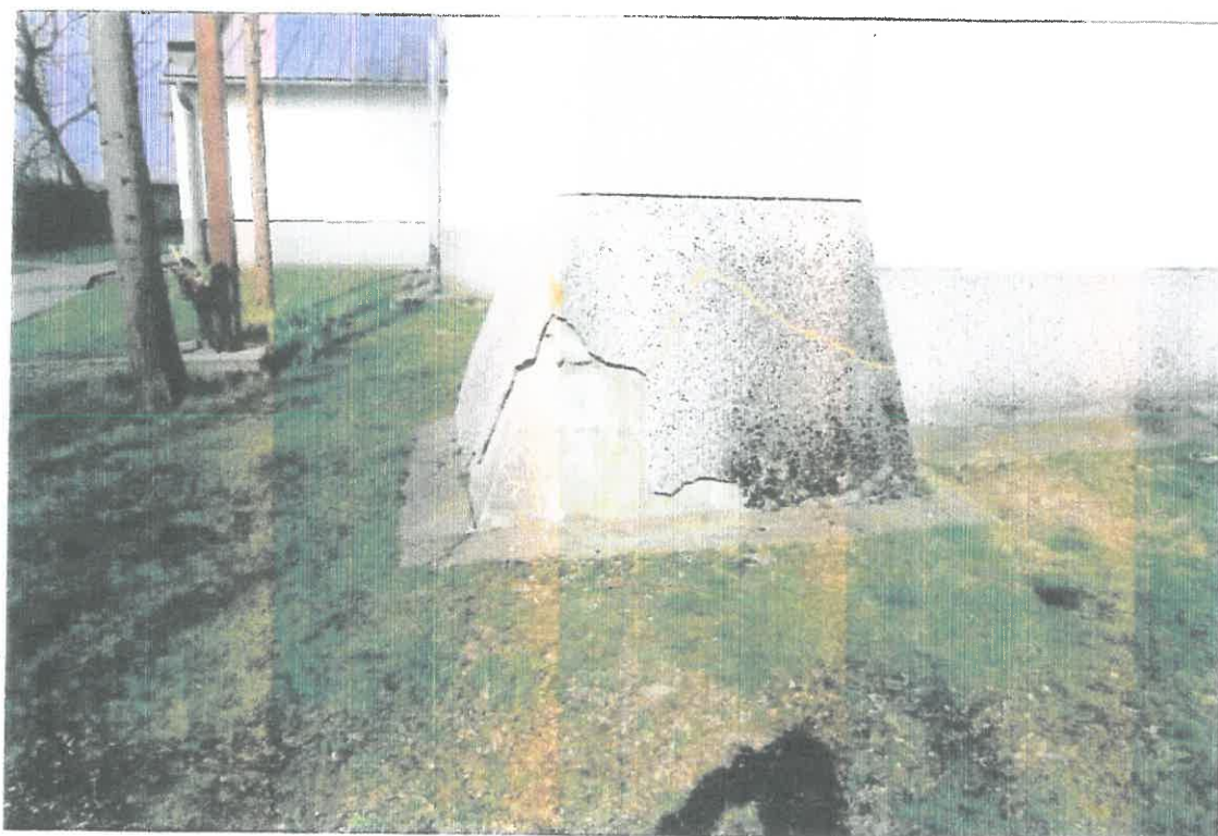
5. Nasiechowice, kościół p.w. ŚŚ. Wita, Modesta i Krescencji – cokół szkarpy południowo – wschodniej, kamienny pokryty cementowym lastrykiem.
