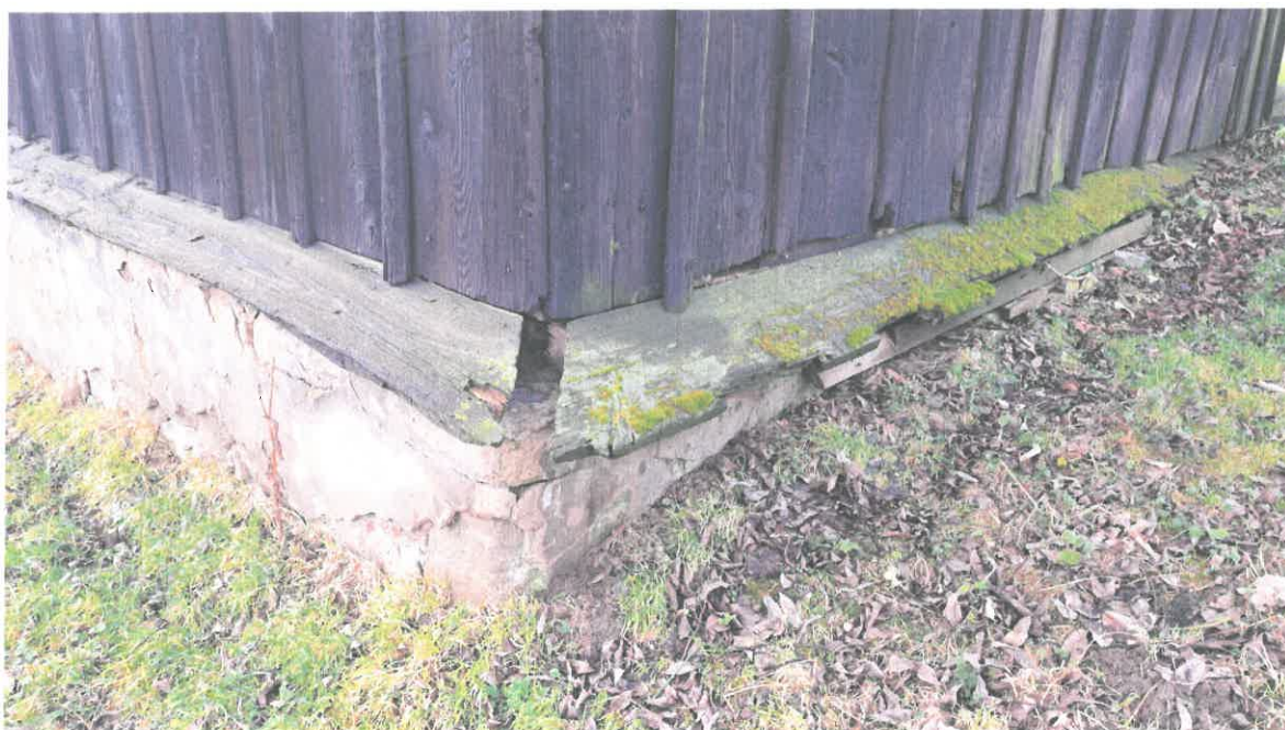
Fot. 2. Widok od zewnątrz na południowo – wschodni narożnik budynku, Widoczne zniszczenie wyprawy tynkarskiej ściany fundamentowej oraz desek zasłaniających podwalinę. Po prawej stronie zdjęcia widoczne zasłonięcie ziemią lica elewacji – fundamentów i elementów drewnianych. Wyk. Ł. Szatanek.
