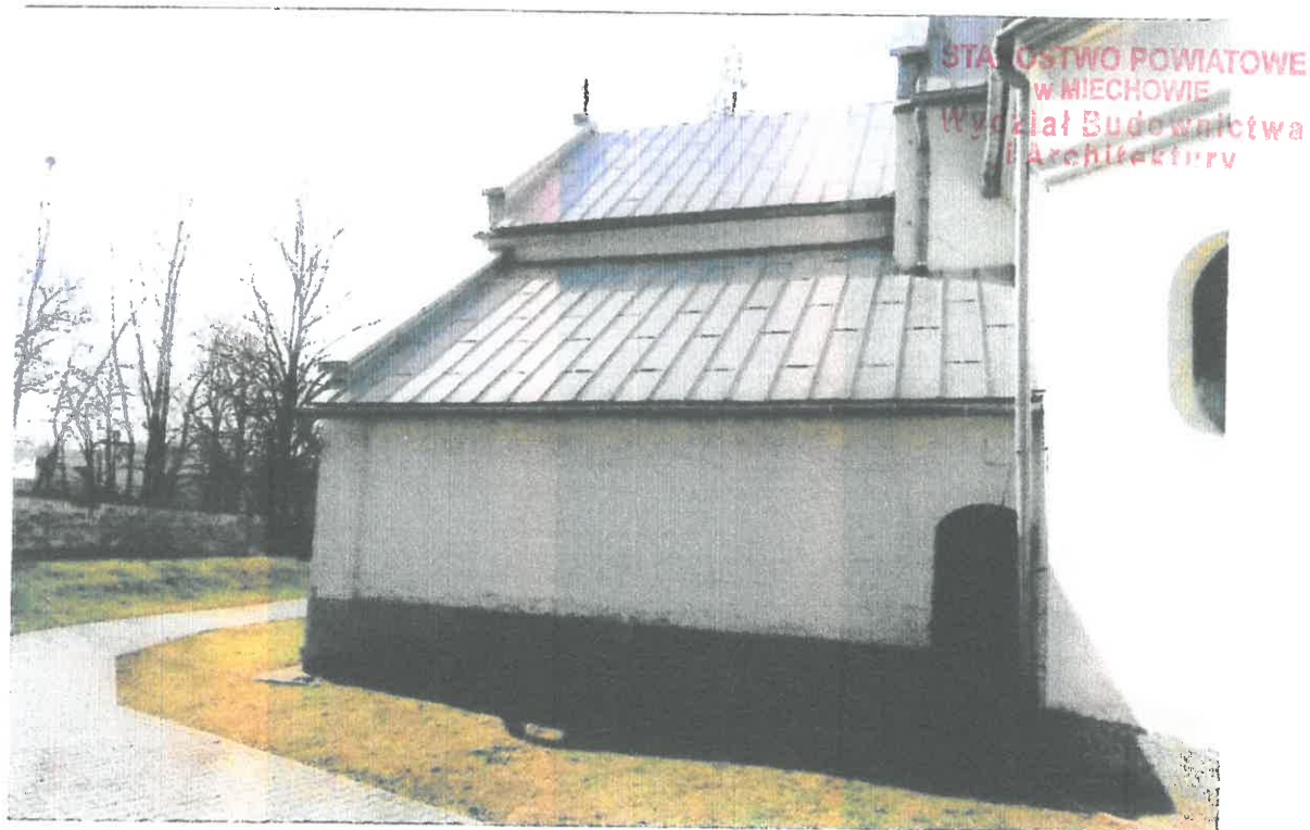
8. Nasiechowice, kościół p.w. ŚŚ. Wita, Modesta i Krescencji – wschodnia ściana zakrystii, zawilgocona, cokół kamienny pokryty cementowym lastrykiem.
