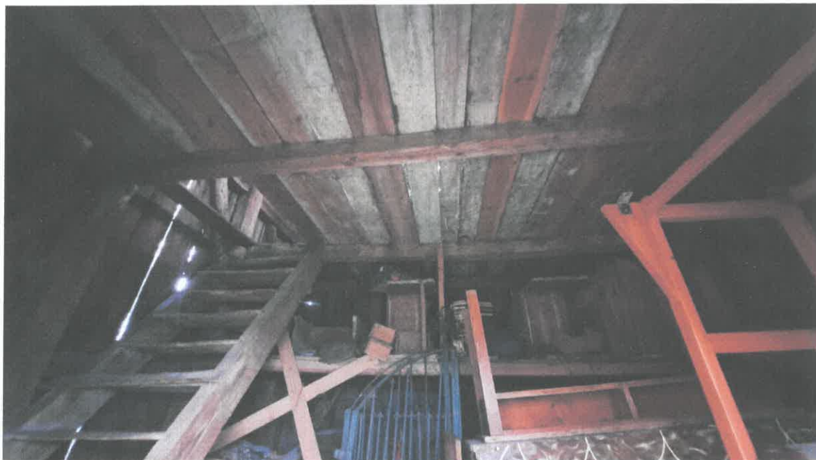
Fot. 4. Wnętrze dzwonnicy – kondygnacja parteru. Widoczne schody prowadzące na pierwszą kondygnację oraz ugięcie belek podtrzymujących strop pierwszego piętra. Widok od strony północnej. Wyk. Ł. Szatanek.
