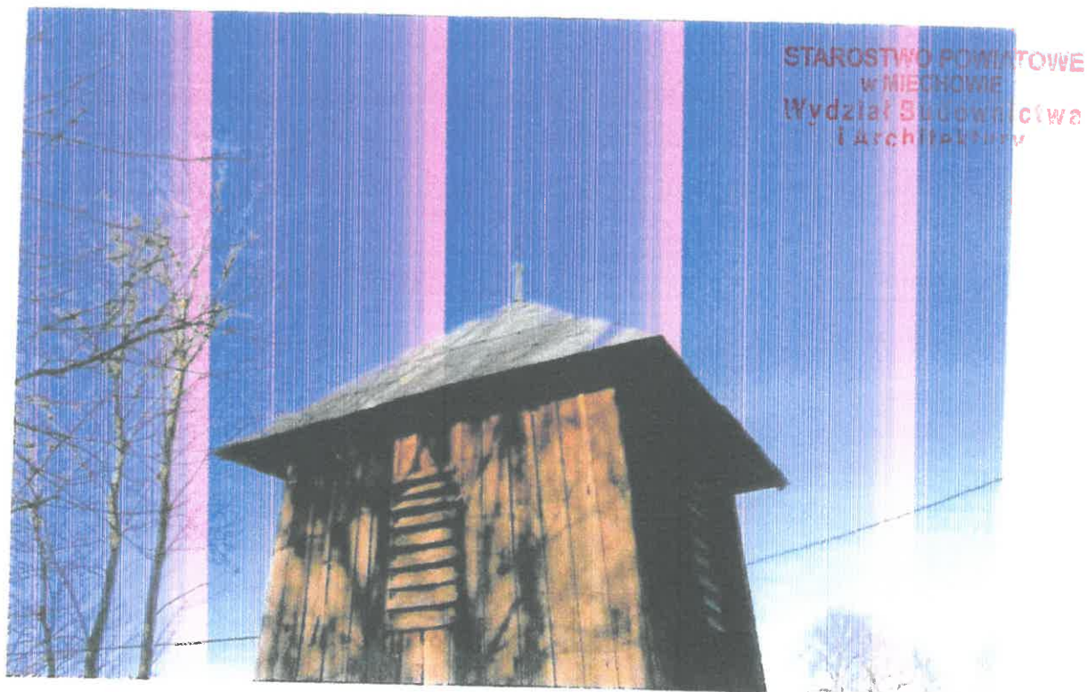
22. Nasiechowice, drewniana dzwonnica z 1740 r. – czterospadowy dach dzwonnicy pokryty papą.
