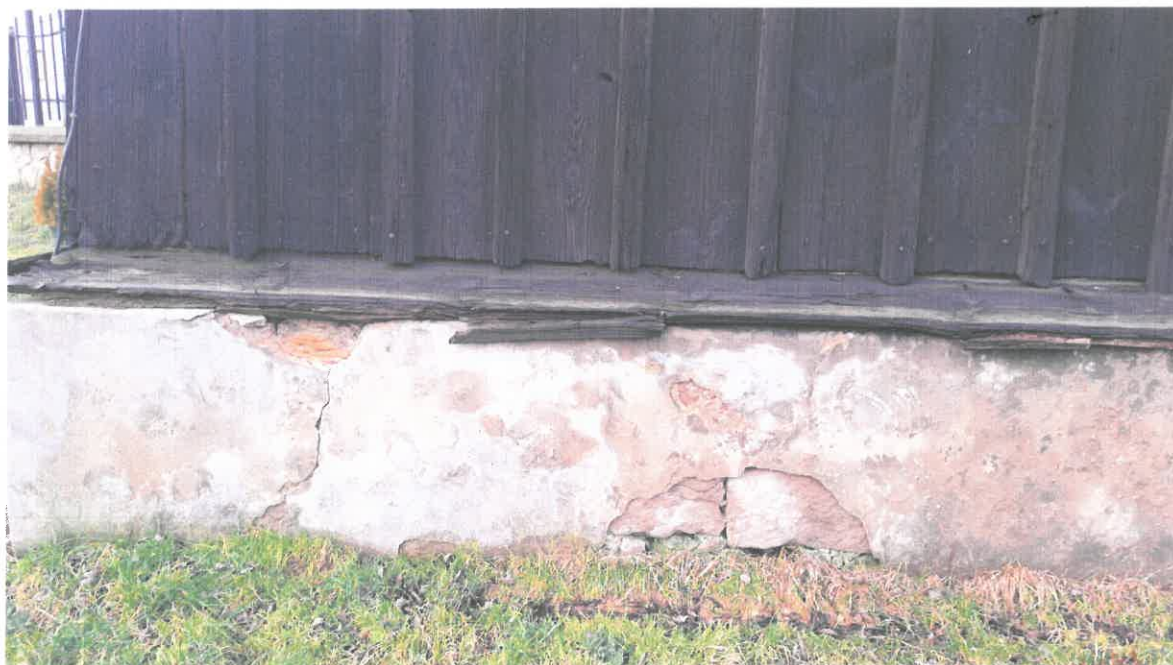
Fot. 3. Elewacja południowa – widok zniszczonej ściany fundamentowej z odspojonym tynkiem odsłaniającym kamień. Wyk. Ł. Szatanek.
