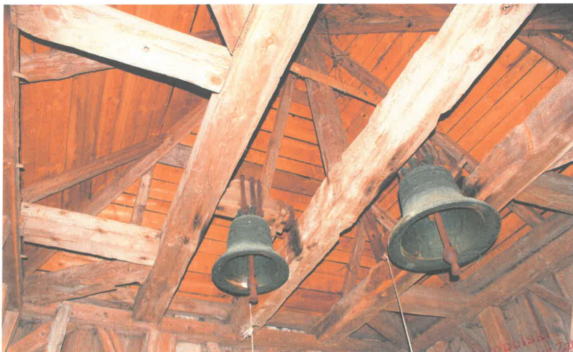
Fot. 9. Widok więźby dachowej i mocowania dzwonów. Wyk. Ł. Szatanek.
