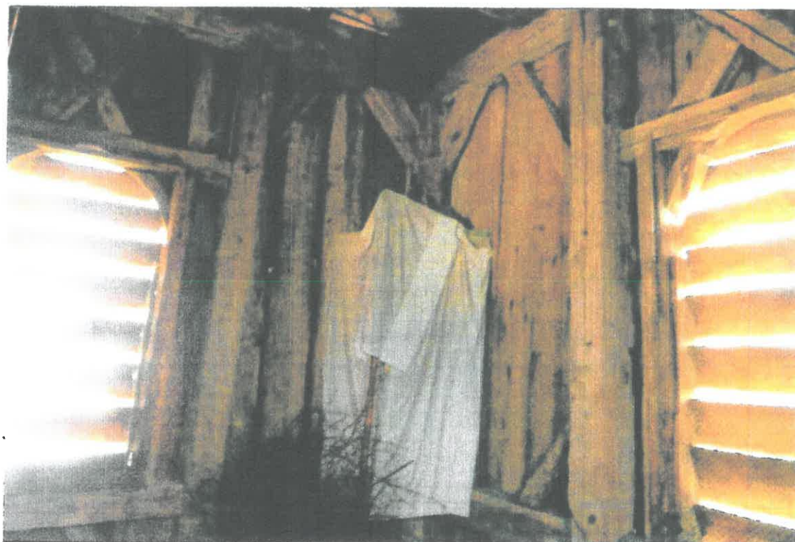
25. Nasiechowice, drewniana dzwonnica z 1740 r. – wnętrze drewnianej dzwonnicy z widokiem konstrukcji słupowej i żaluzji okien.
