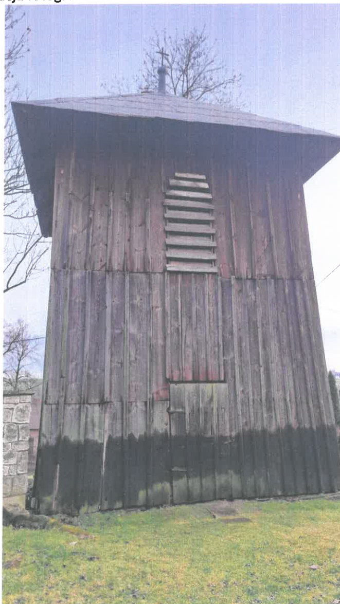
Fot. 1. Ogólny widok dzwonnicy od strony północnej. Widoczne przecięcie i wymiana okładziny drewnianej na lewo od drzwi wejściowych oraz zawilgocenie całej powierzchni drewnianej do wysokości ok. 150 cm. Wyk. Ł. Szatanek.
