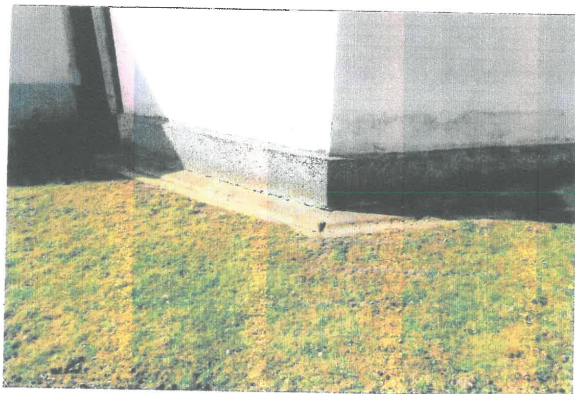
9. Nasiechowice, kościół p.w. ŚŚ. Wita, Modesta i Krescencji – cokół kaplicy Najświętszego Serca Pana Jezusa pokryty cementowym lastrykiem, tynki ścian zawilgocone.
